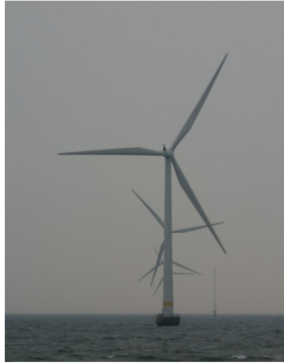
Figur 3.4 Fotografi på en Siemens SWT-2.3-93 bakifrån under drift.
